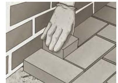
В местах примыкания мощения к границам плитки всегда остаются пустоты, меньше целого кирпича по размеру. Они заполняются доборными кирпичами, которые изготавливают при помощи отрезной пилы («болгарка» или циркулярная пила с диском для камня).
