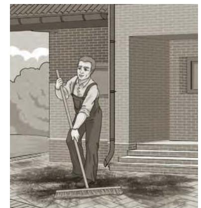
Швы финишно заполняются с помощью щетки. Для заполнения используют песок мелкой фракции ( $M_{k} < 2.0$ ). Проливка швов способствует уплотнению песчаного заполнителя. Для заполнения швов можно использовать цветные смеси. Уплотнение облицовочного слоя производится при помощи виброплиты ( $m < 100 \text{ кг}$ ) с защитной плитой из неопрена.
